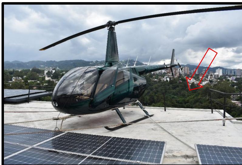
Fotografía No. 9 Vista de la parte de la baranda de seguridad faltante.
