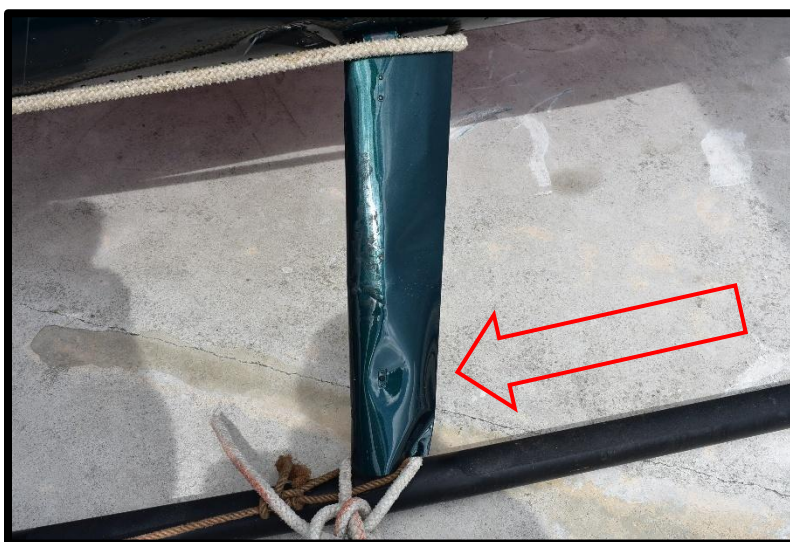
Fotografía No.11 Vista del Skid lado izquierdo posterior dañado
